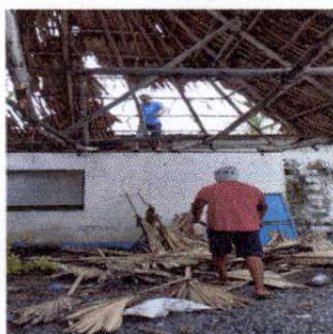
Foto1: SUSTITUCIÓN DE TECHO DE PALMA, POR LAMINA TROQUELADA ALUZINC CALIBRE 26
