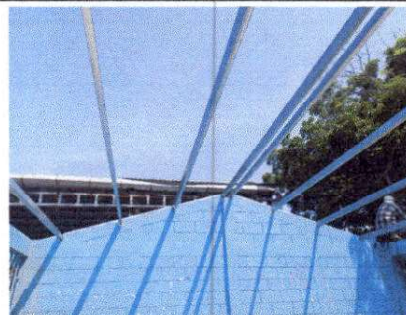
Foto 4: SUSTITUCION DE ESTRUCTURA DE METAL, POR METAL
