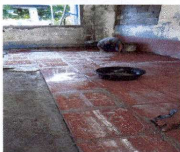
Foto 5: SUSTITUCION DE PISO DE CEMENTO LIQUIDO POR PISO CERAMICO
