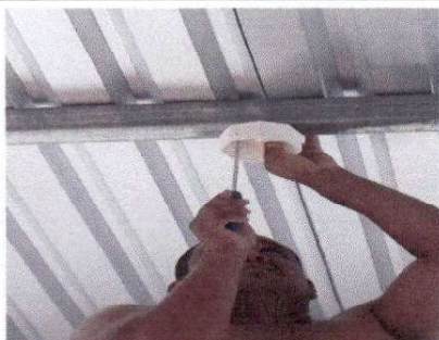
Foto 7: SUSTITUCION DE FOCOS AHORRADORES, Y PLAFONERAS, EN TODOS LOS MODULOS
