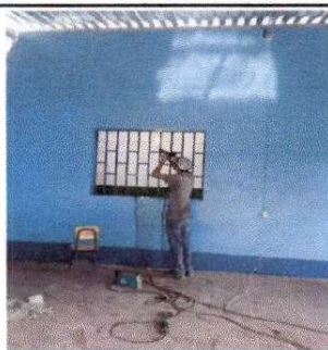
Foto 9: FABRICACION E INSTALACION DE BALCONES DE HIERRO EN VENTANAS
