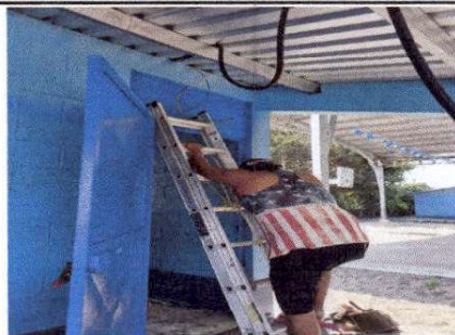
Foto 8: SUSTITUCION DE INTERRUPTORES DOBLES
